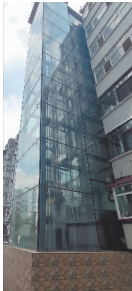
哈尔滨工程大学家属区10个单元加装电梯已正式运行9个月。
