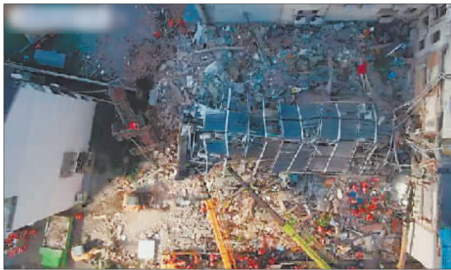
苏州四季开源酒店坍塌搜救工作结束。
