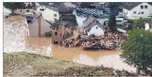
德国境内被洪水冲垮的房屋。
