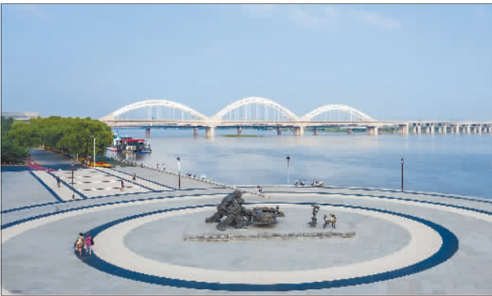
道外江畔改造，全新景阳广场亮相。据悉，自7月12日起，哈市将滨洲铁路桥至景阳广场段、北七道街至北头道街段车行道调整为步行街。 哈报手机记者 刘琴 摄
