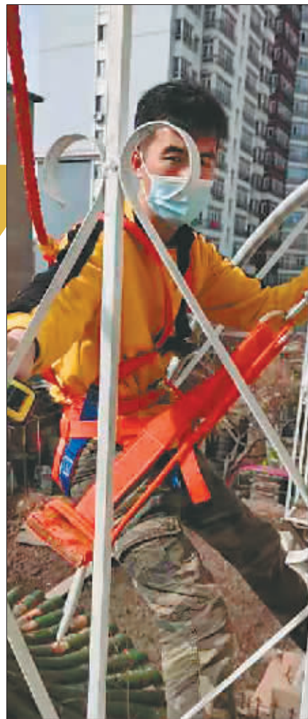
王鹏为客户安装空调。
