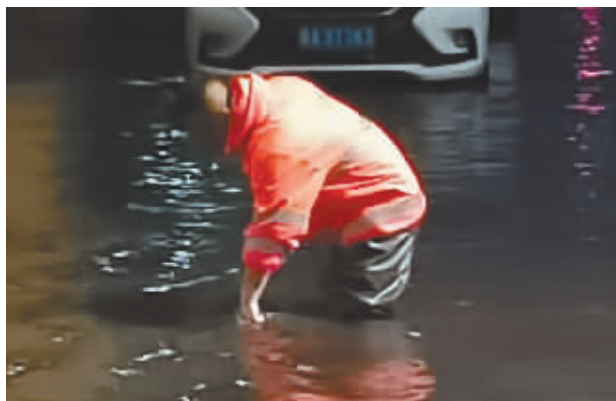
道外二十道街与靖宇街交口,工作人员正在排涝。
