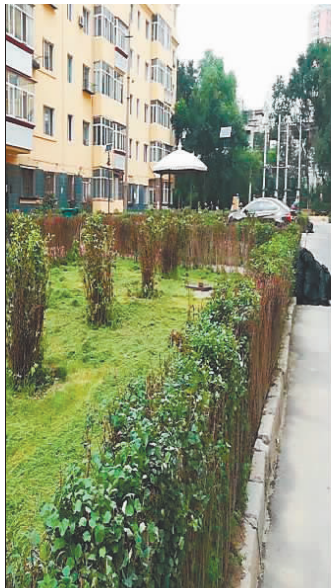
对小区庭院进行绿化改造。
