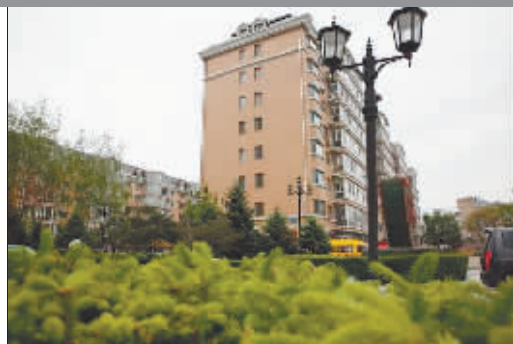
改造小区院内路灯。
