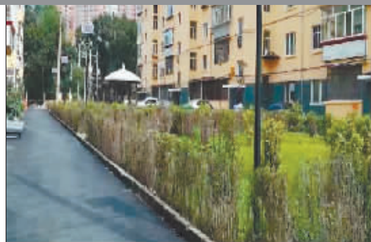
楼面粉刷及路面翻新。
