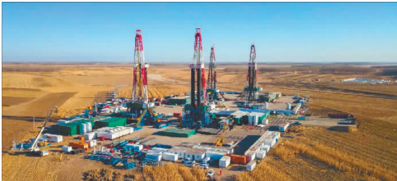
钻井队施工现场。
