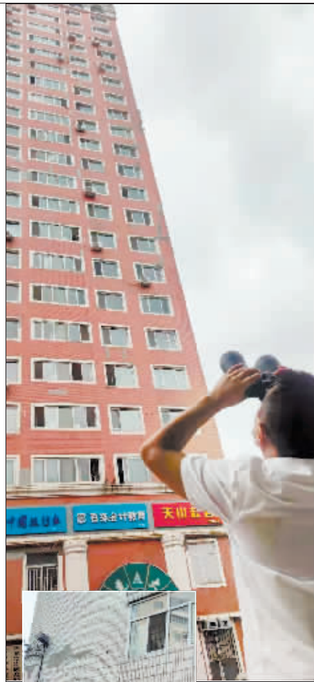
房管员查看建筑外墙。
