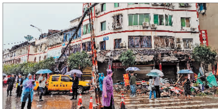
16日,泸县福集镇大田南街因地震受损的房屋。
