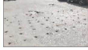
香山路与浦江路交会区域正处于上述施工区域内，“饼干路”现象是施工单位刨开路面前的一道工序。道桥专家介绍，在刨开路面前用机械在路面上整齐地打出一排排小坑可以击碎道路表面混凝土，破坏路面整体张力，使得施工效率提升，比直接用机械在路面上杂乱无序地开挖效率更高，因此便出现了“饼干路”的现象。
