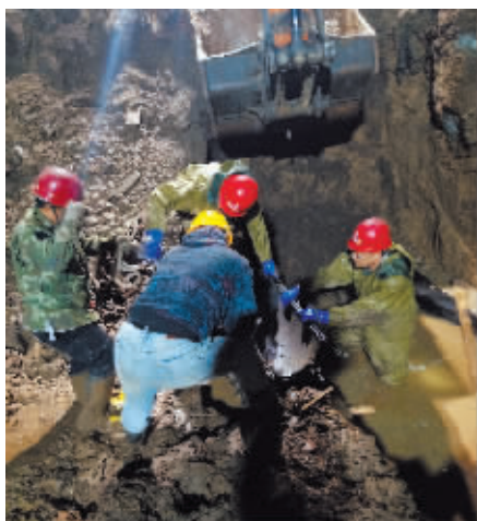
施工人员抓紧抢修。
