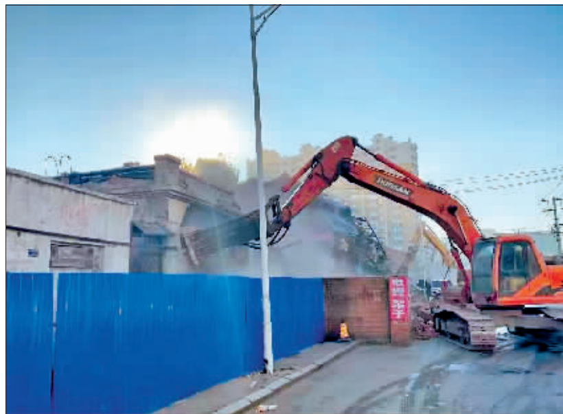
昨天，伴随北十九道街与集良街交口处最后一处平房被拆除，道外区二十道街地段棚改项目实现全面征拆净地。任正岩 本报记者 杜菲菲 文/摄
