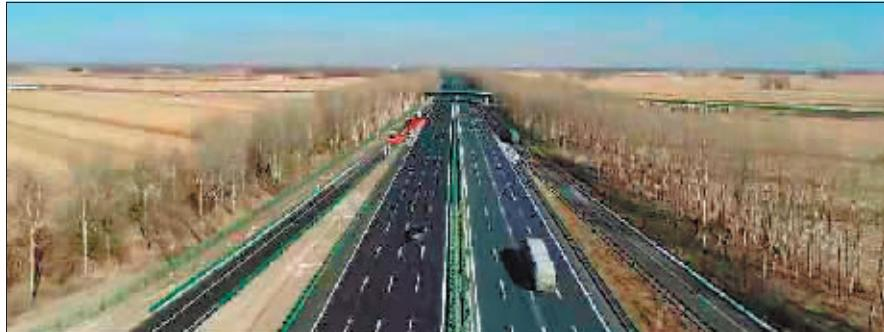
最重要的公路之一。京哈高速黑龙江段改扩建项目起于吉黑省界拉林河大桥,路线跨京哈铁路,途经双城区、平房新区、南岗区,止于哈尔滨城市主干路学府路,路线全长70.955公里。2019年5月开工建设,历时29个月,实现建成通车。完工后,路基宽度由28米增加到42米,四车道改扩建为八车道,显著提高了车辆通行能力。
