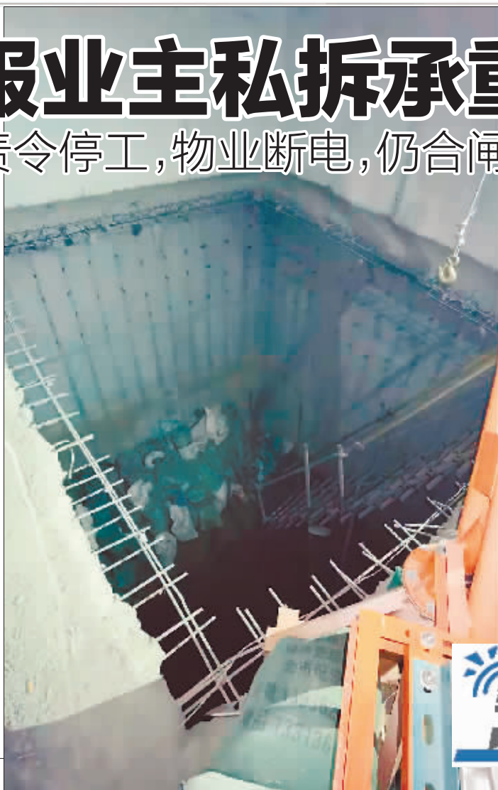
商服私拆的地下室承重基础楼板。 小区居民供图
