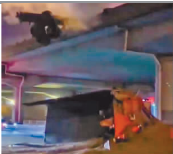
坠桥厢体已严重变形。
