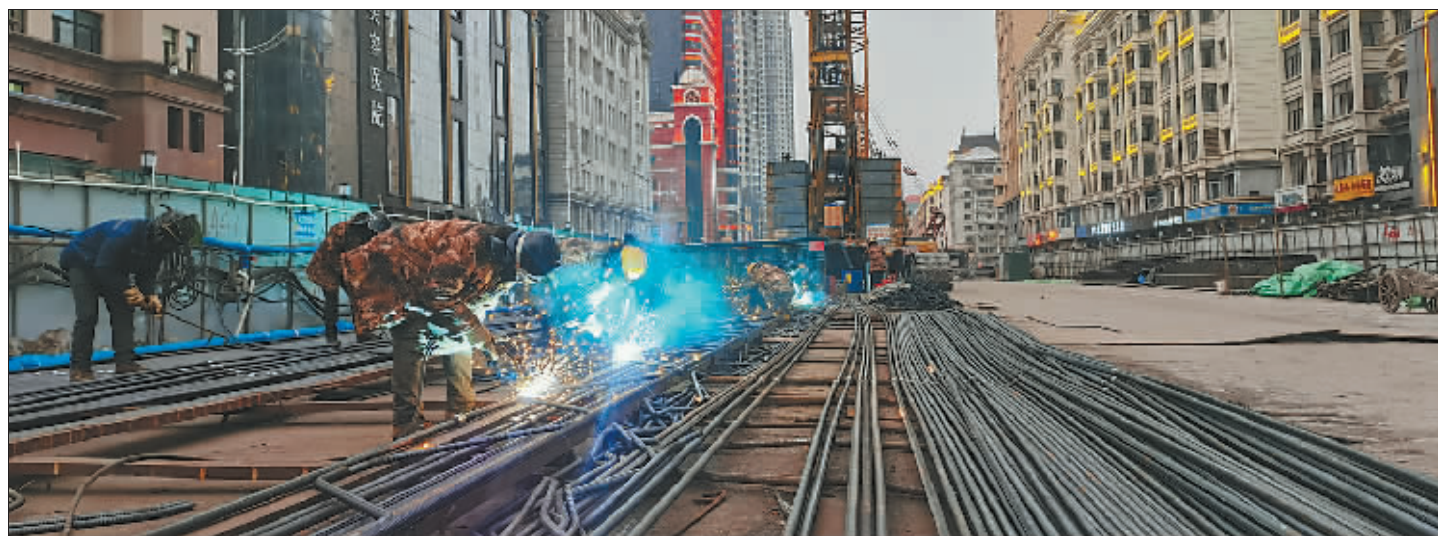
友谊路地铁施工现场,电焊工们正在进行焊接作业。 耿占东摄
