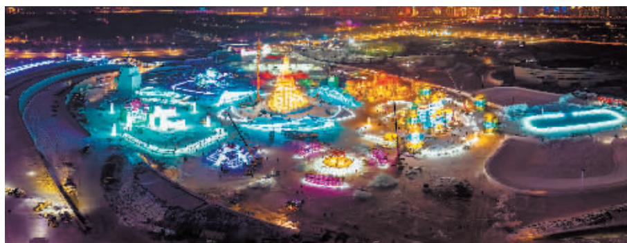
入夜后冰雪大世界建设现场。
