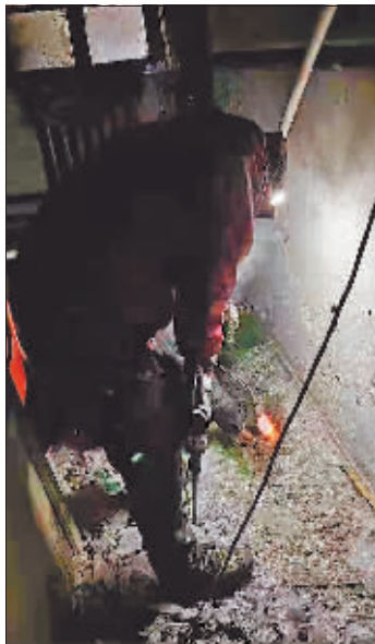
抢修人员寻找被冻管线。
