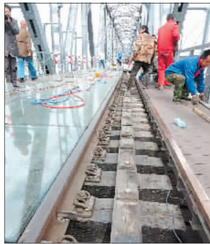
2016年10月玻璃栈道铺设场面。
