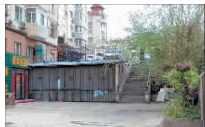
现今安道街与抚顺街原路基断面落差。
