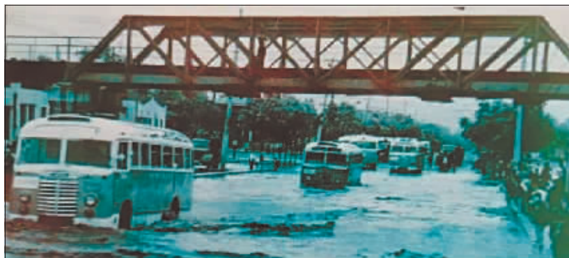
昔日道里支线新阳路立交桥。
