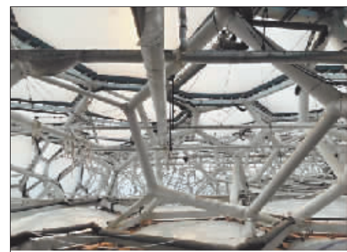
在“冰立方”顶棚两层钢结构气枕间敷设遮挡膜。
