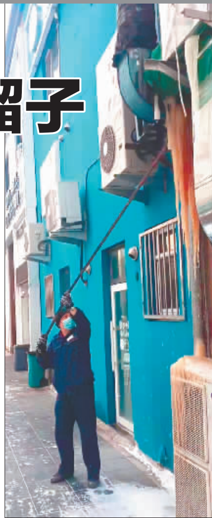
工作人员清理楼顶积雪和冰溜子。
