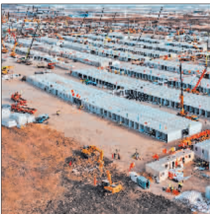
近日,位于长春市宽城区的兴隆山保税区方舱隔离点正加紧建设。
