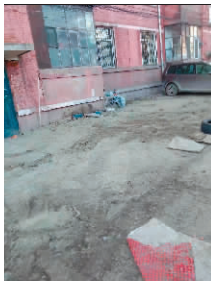
结电街正在进行回填平整。 居民供图
