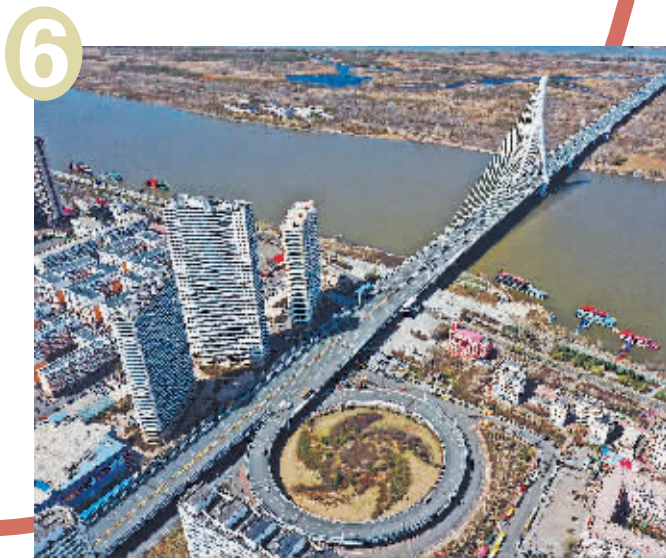
6 松浦大桥(道外区)
