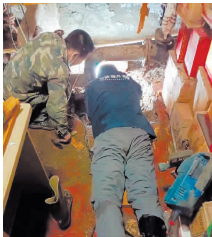
工作人员在修复地下管线漏点。
