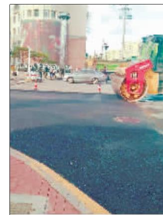
维修质量关，做到了道路切割规矩到位、道路翻浆深度修复、面层铺装碾压到位。
