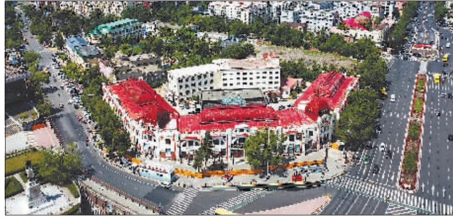
在施工过程中,将采用传统工艺,按原形制、原结构、原材料、原工艺进行修复,且尽可能地使用原构件,从而消除险情、隐患。
