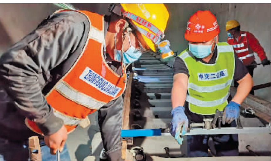
地铁铺轨施工现场。
