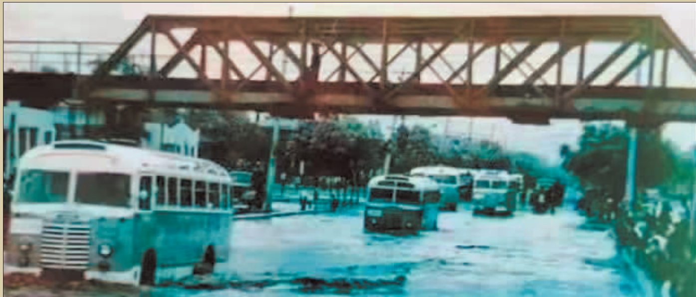
20世纪五六十年代,横跨新阳路的安道街铁路桥。
