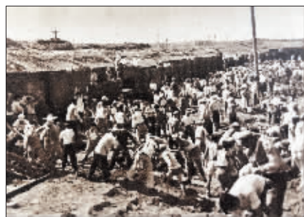
▲全民上阵，挖土装袋。
