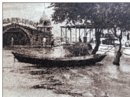
▲铁路江上俱乐部门前的江水。
