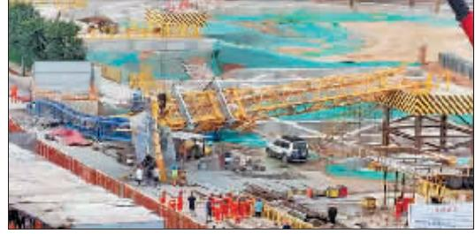
23日，江苏省住建厅公布南京一工地塔机倾覆致2死2伤事故原因，初步分析系塔吊安装工人未按规范流程及时安装固定销轴，安装单位未及时发现隐患，制止后续作业。
