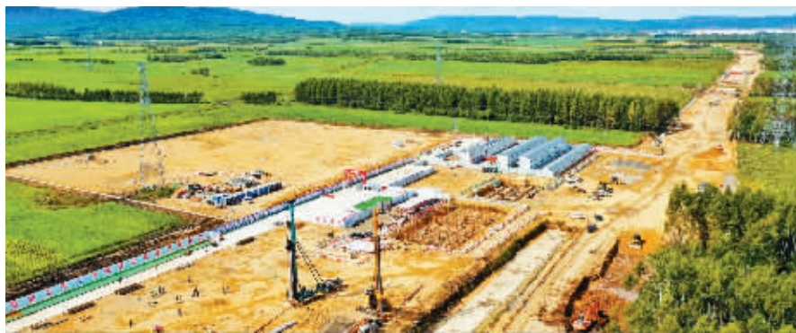
伊春西站正式开工。
