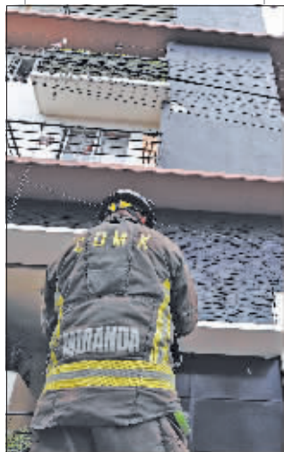
消防队员查看建筑物的损坏情况。
