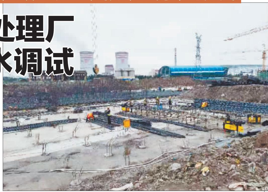
于今年3月底动工开建,该处理厂采用全球领先的MBR膜技术处理工艺替换传统沉淀池;入厂污水经粗格栅、细格栅、沉砂池层层“拦截”,再经过生物反应池的降解,最后进入膜处理车间,通过消毒接触池的净化,处理后达标水排入何家沟水系,出水水质达到一级A。
