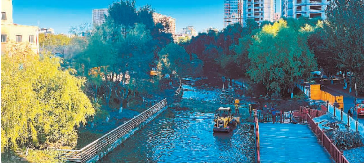
26日，南岗区文景头道街附近马家沟河上，马家沟跨河桥工程正在进行中。据了解，该工程位于马家沟与文景头道街高架桥交会处，主桥长45.1米，桥净宽2.6米，主体采用钢箱梁结构，桥体栏杆扶手及桥体下方将设置灯带亮化，建成后将成为马家沟河上又一亮点。
