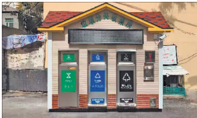
南岗部分小区设置的全封闭式垃圾智能分类投放厢房。
