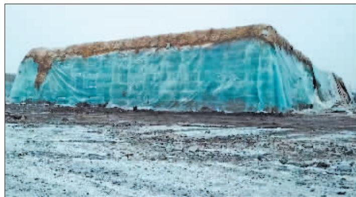
为冰体提供适宜的储存条件——低温、避光、隔热、密封,即使在气温超过30℃的炎热盛夏,冰体也不会融化。
