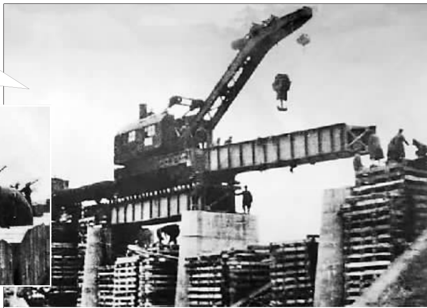
▲1948年8月铁道纵队三支队修复陶赖昭松花江铁路大桥。
