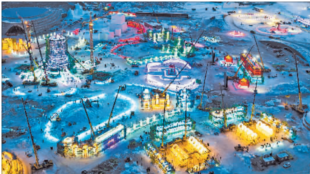
第24届哈尔滨冰雪大世界园区灯火通明,建设项目有序进行中。
