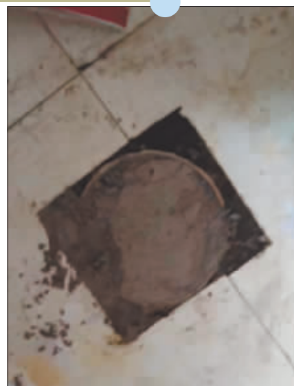
居民将家中卫生间地漏堵住,但污水仍然往上返,流满卫生间。
