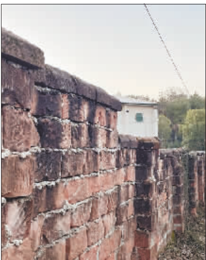
粮库外部的围墙。
