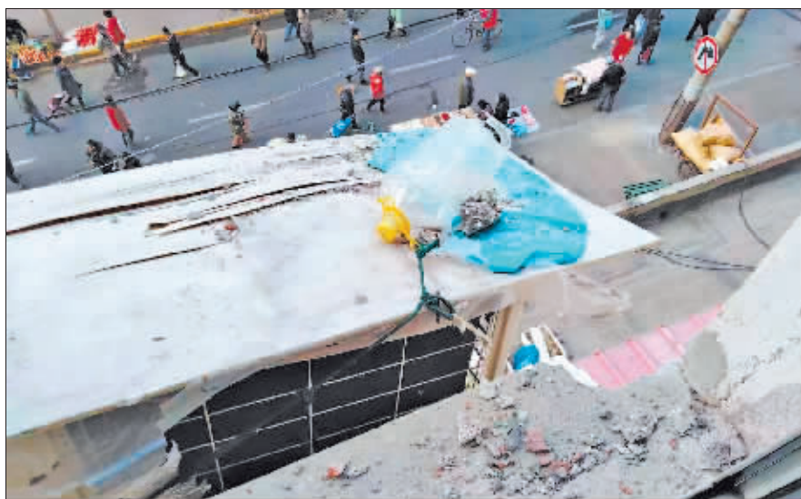
石女士家的空调外挂机被外墙脱落物砸坏。 图片由居民提供
