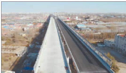
机场二通道项目桥面系施工。
