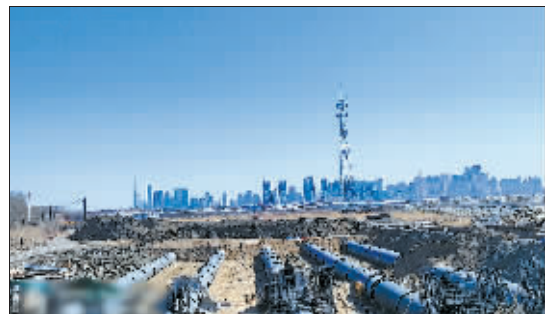
松花江水源上移项目管线敷设施工现场。
