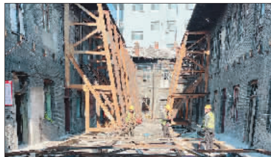
中华巴洛克三期改造项目加固施工现场。
