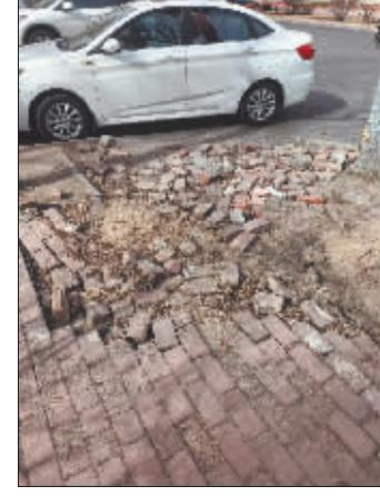
造成崴脚等安全隐患。目前哈市已进入春季，该步道板破损处沙土裸露，大风一吹沙土可能会随风飘散，会对城市环境产生影响。
