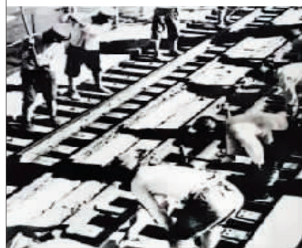
▲20世纪30年代中东铁路全线进行拨轨作业。
