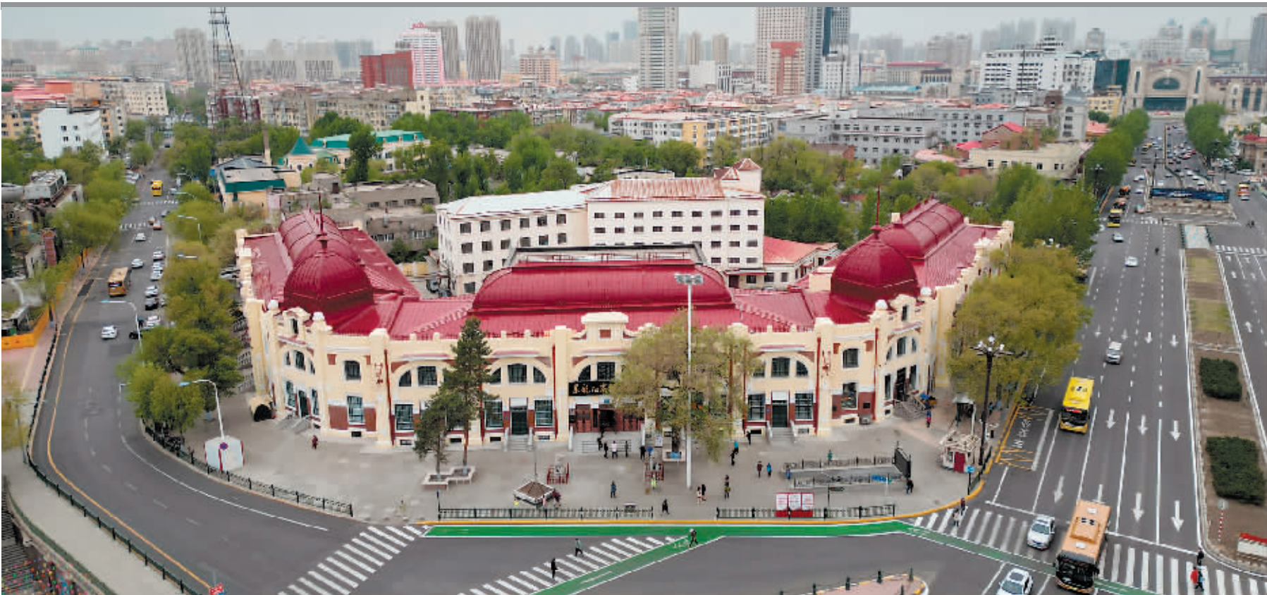
经过近一年的修缮,黑龙江省博物馆昨起试运行开放。 本报记者 孙岩 摄
