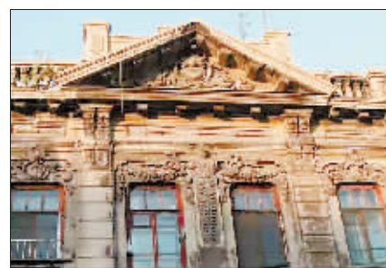
▲中华巴洛克建筑楼顶的丰富雕饰。
