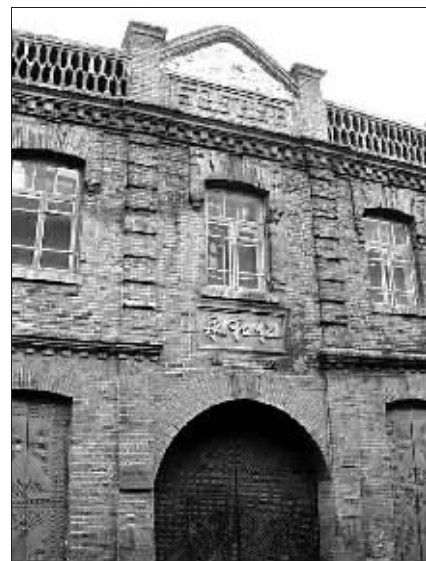
▲仁和永外墙体现状。
