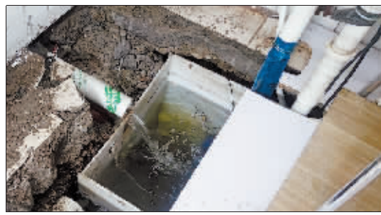
工作人员将积水汇集，排到下水井。
