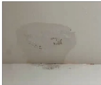
房顶墙面有大片水印。
